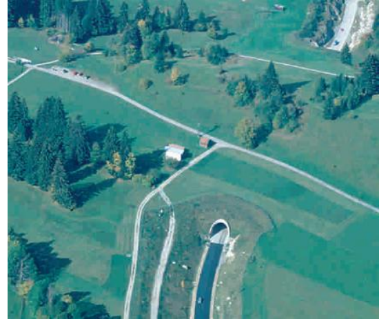
Figuur 7.7: Tunnel in Beieren, Duitsland, foto COST 341
