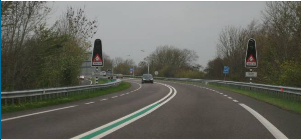
Waarschuwinglichten aan de zuidzijde van de brug. Ook is de overgang in de markering te zien tussen het gedeelte met een maximumsnelheid van 100 km/u en het gedeelte ter hoogte van de brug met een maximumsnelheid van 80 km/u.
