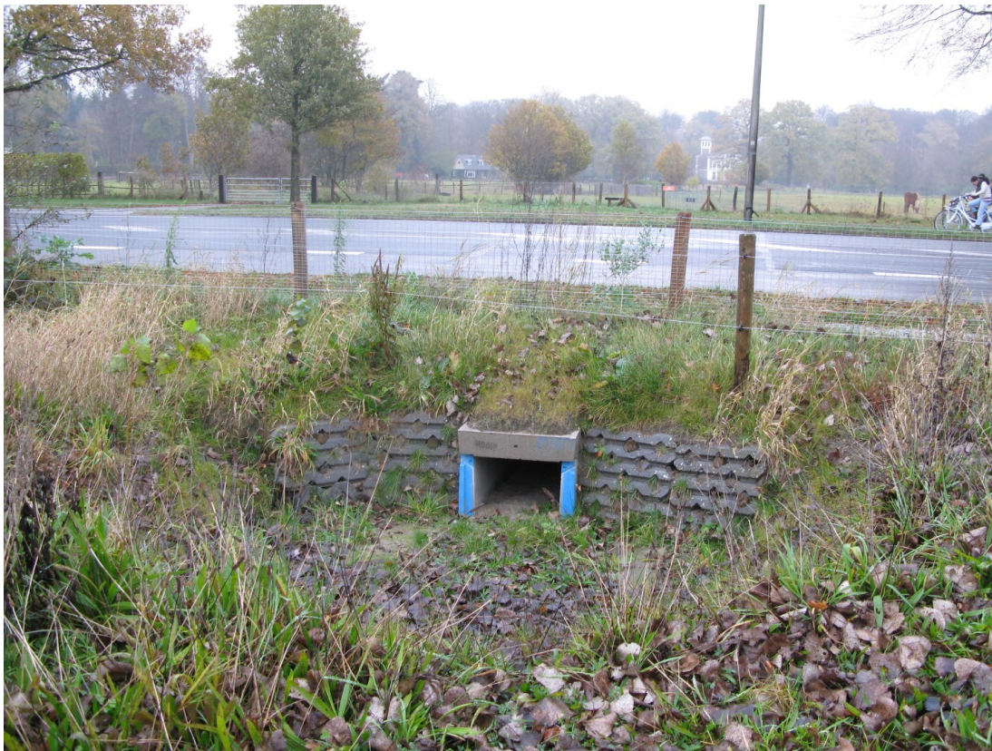
N225 kleine faunatunnel Doorn
