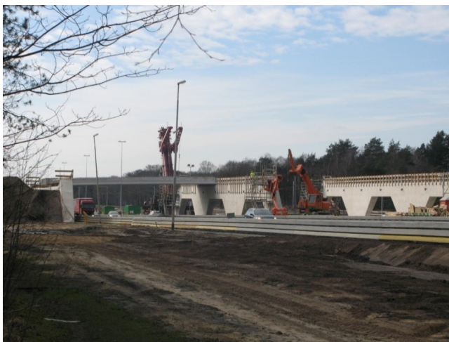
Ecoduct Mollebos A12 in aanbouw (2012)
