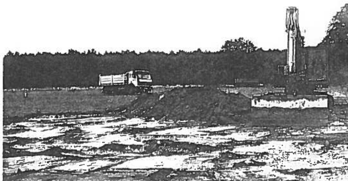
Den festgelegten Umrisse entsprechend, nimmt die Baggerschaufel zunächst den Mutterboden ab
