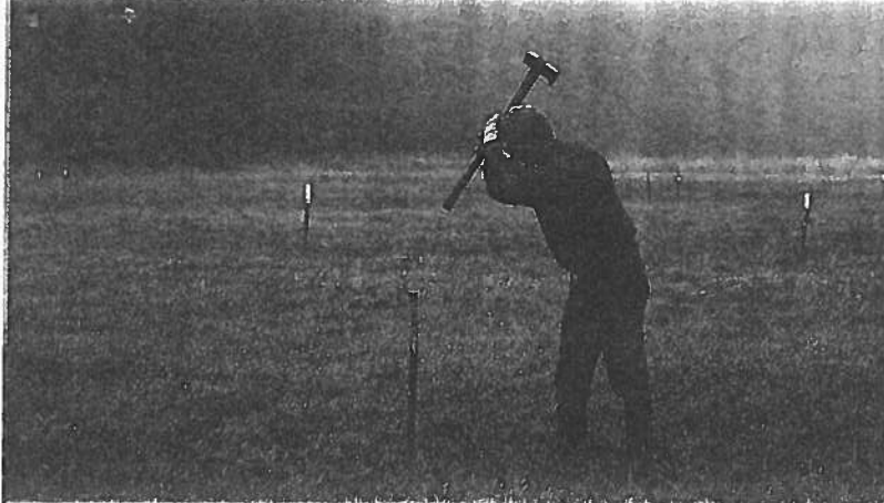
Die Umrisse des Teiches inklusive der Inseln werden zur Orientierung des Baggerführers ausgepflockt
