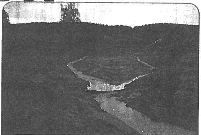
Die Abtragung des Oberbodens aus der intensiv genutzten Wiese soll eine Abmagerung des Standorts herbeiführen und eine natürliche Begrünung durch die umliegenden heimischen Pflanzen gewährleisten (Sukzession).
