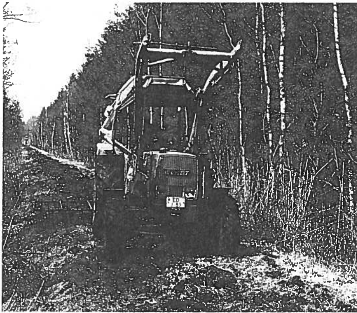
Durch das Auffräsen und Ein ebenen von kaum befahrenen Wegen (den Landwirt ggf. um Hilfe bitten!) werden die ungerne beästen Waldgräser zurückgedrängt, und es entsteht ein günstiges Keimbett für die Einsaat.
